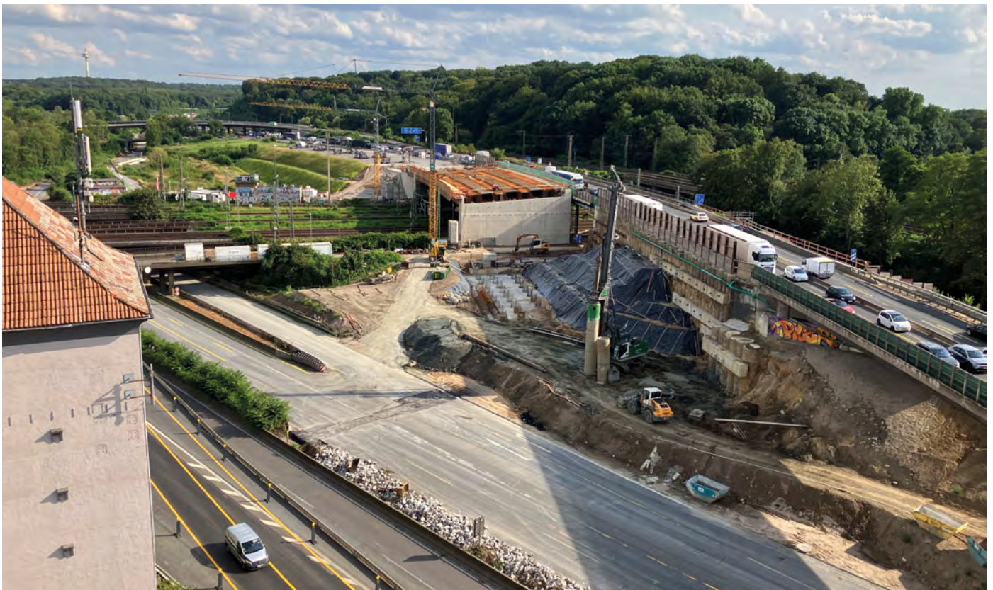
Baustelle Kreuz Kaiserberg
